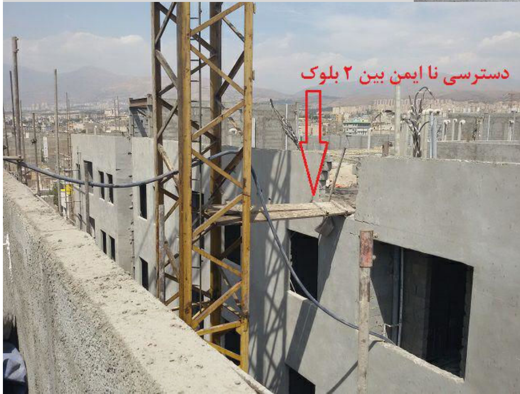
استفاده بسیار خطرناک و غیر ایمن برای دسترسی
