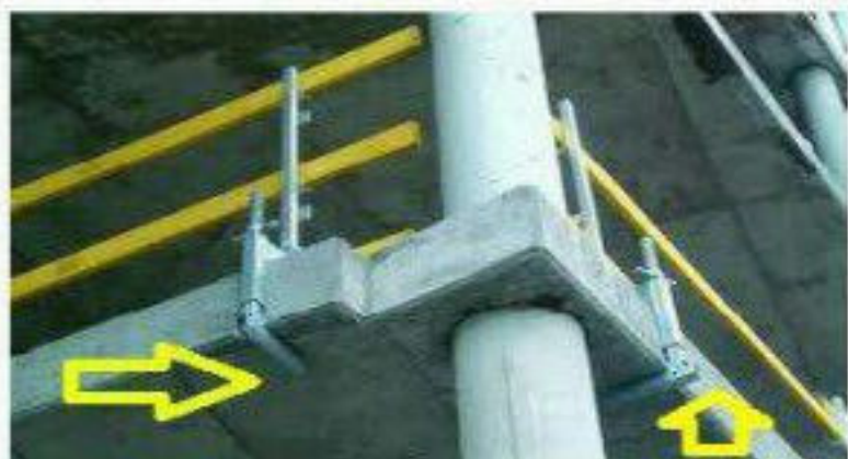
▲ نحوه ثابت کردن پایه های نرده های حفاظتی موقت در اسکلت بتنی
