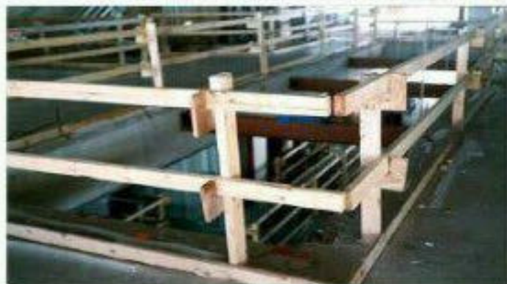
▲ اجرای نرده حفاظتی برای ایمن سازی بازشوی نورگیر
